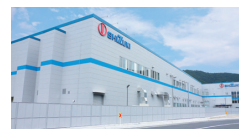
岡山指月第3工場 (エコカー向けコンデンサ製造棟)
